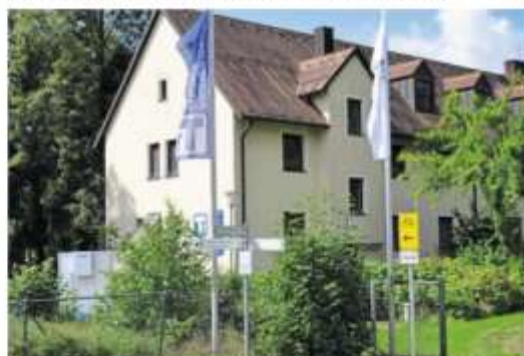
Im Gebäude der Jugendherberge Tannenlohe ist das Jugendmedienzentrum seit 15 Jahren im Dachgeschoss untergebracht. Bald gibt es mehr Platz im Stockwerk darunter: Hier entstehen Büros für das erweiterte Team und ein richtiges Aufnahmestudio. 044: 31
